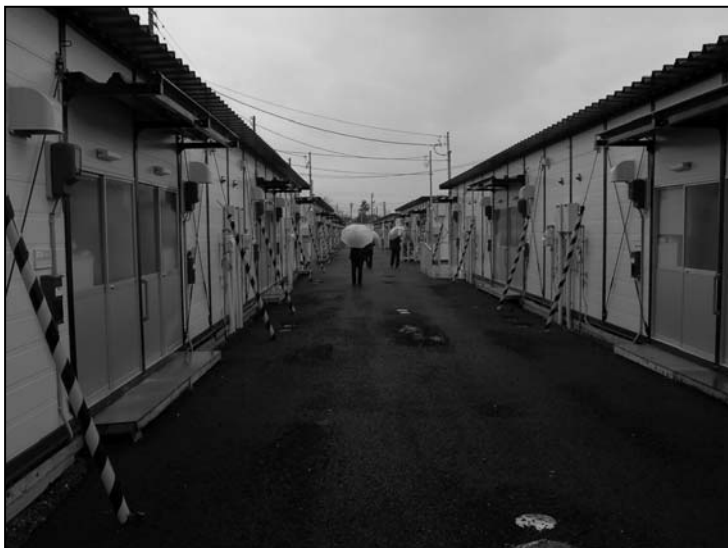
立ち並ぶ仮設住宅。視察先には、世帯人数により9坪と12坪の2種類のプレハブ住宅が建てられていました。
